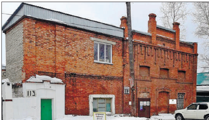
Рис. 1. Объект культурного наследия регионального значения «Склады торговые», начало XX в., по адресу: Алтайский край, г. Барнаул, ул. Никитина, 113.
