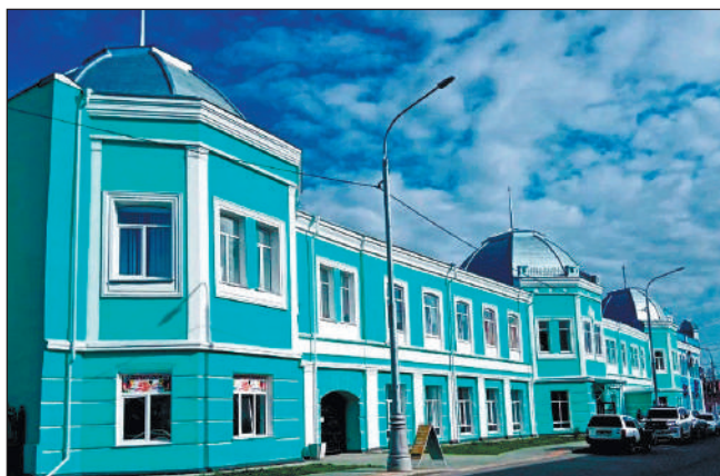
Рис. 2. Объект культурного наследия регионального значения «Дом Морозова», начало XX в., по адресу: Алтайский край, г. Барнаул, ул. Ползунова, 34а. Вид с юга. Фото автора 2022 г. Fig. 2. The object of the cultural heritage of regional significance, "House of Morozov", beginning of the 20 th century at the address: Altai Krai, Barnaul, Polzunova st., 34 a. View from the south. Photo by the author of 2022
